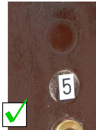
Obr. 14: V pořádku. Menší nepravidelnosti povrchu a jeho zbarvení
